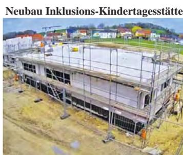
Dank günstiger Wetterlage konnte das erste Geschoss im Rohbau fertig gestellt werden. Es erfolgte die Betonarbeiten für die Decke. Nun geht es mit dem Obergeschoss weiter. (Foto: Gemeinde Steina)
