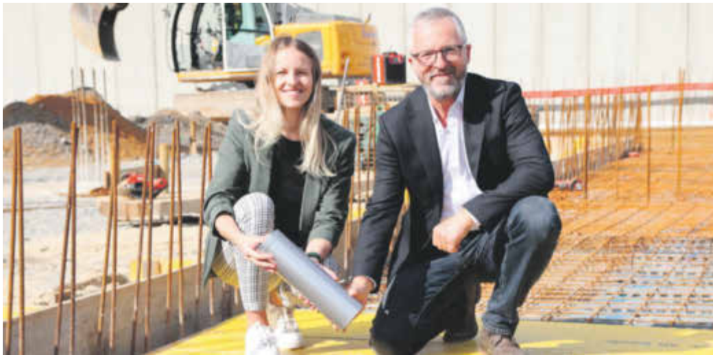
Junior Geschäftsführerin Elisa Winter sowie Senior Geschäftsführer Heiko Winter versenken die Kartusche zur Grundsteinlegung.
